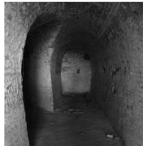
Téglalobtozatú táró bejárati szakasza
