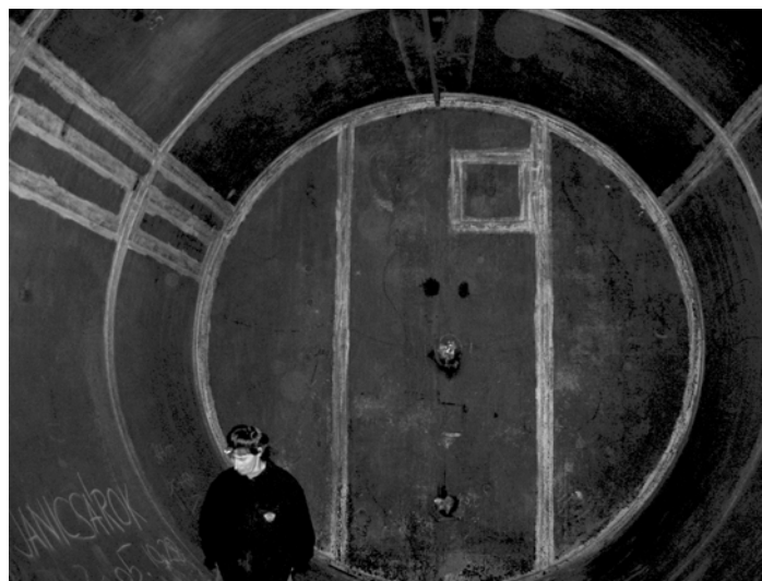
Gáztartály acéllemezei hegesztett csatlakozásokkal
